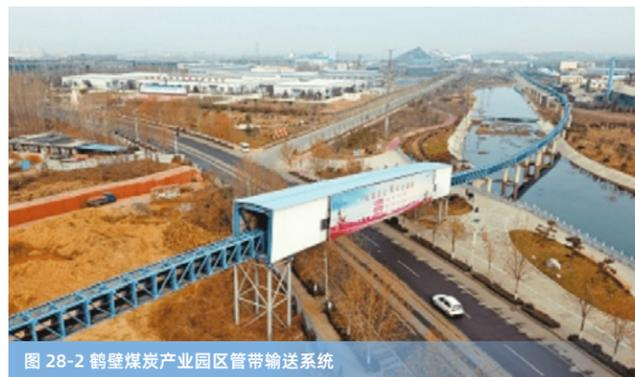
图 28-2 鹤壁煤炭产业园区管带输送系统
