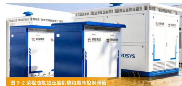
图 9-2 荣程油氢站压缩机撬和顺序控制阀箱
